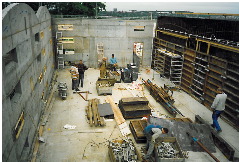
Håndværkerne er i gang med opførelsen af tilbygningen i foråret 1996.
